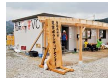
陸前高田市災害ボランティアセンター
